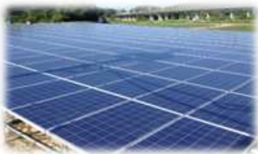
太陽光発電設備(茨城)
